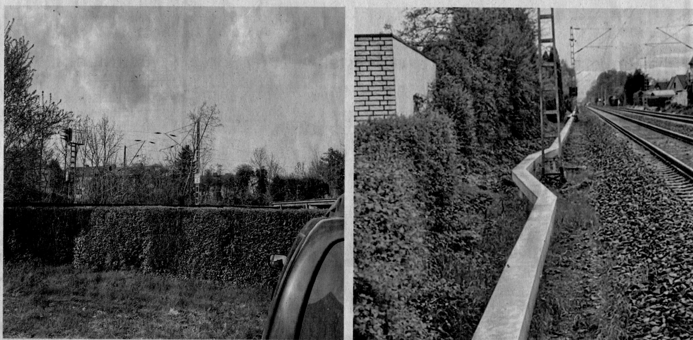
Kampf um mehr Lärmschutz: Die Gärten der Anwohner grenzen zum Teil direkt an die Bahnlinie (links). Auf der östlichen Seite der Bahnstrecke Hamm – Unna wurde vor einiger Zeit ein Kabelkanal verlegt, in den, so die Hoffnung der Anrainer, weitere Kabel verlegt werden könnten, um so den Bau einer Lärmschutzwand auf der östlichen Seite möglich zu machen.
