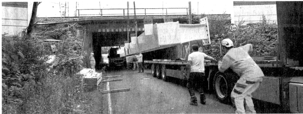
Die Lärmschutzwand in der Selmigerheide wird ausgebaut – aber nur auf einer Seite.
