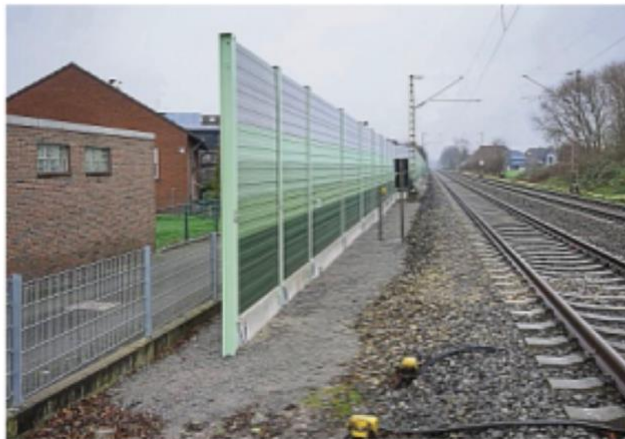
Den Lärmschutz an der Bahnstrecke Hamm – Unna in der Selmigerheide gibt es nur auf einer Seite. ROBERT SZKUDLAREK
